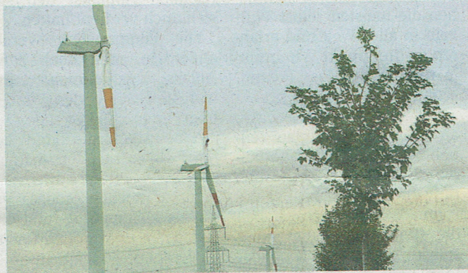
Insgesamt neun Windkraftanlagen liefern in Fröndenberg regenerative Energie.
